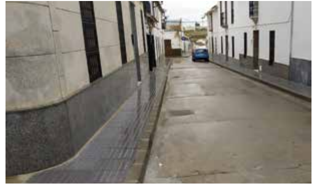
Estado de la calle Calatrava tras la actuación que se ha realizado
