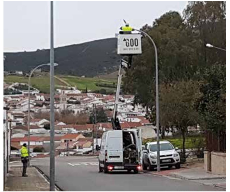
Trabajos de reposición de las farolas led
